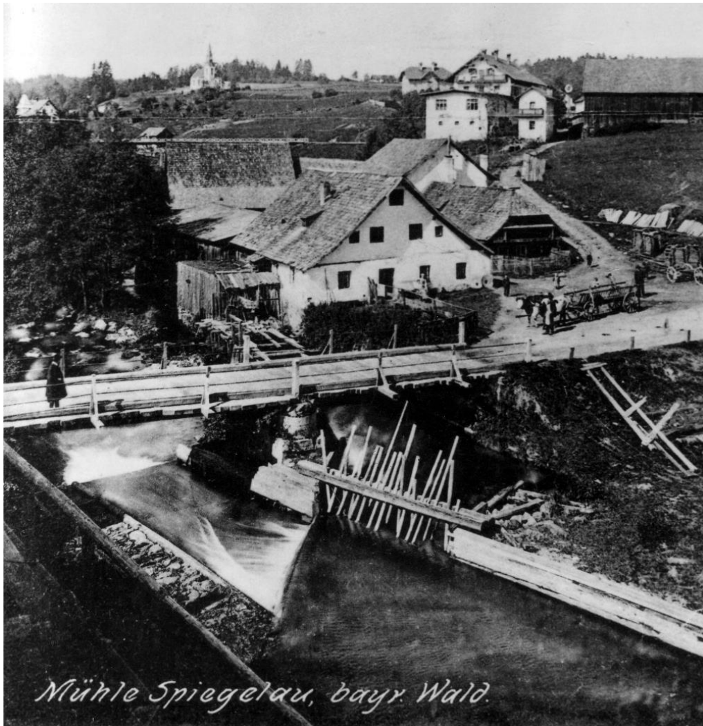
Die Mühle um 1910: Im Hintergrund die Wehranlage mit dem Grobrechen aus Holzstangen. Die Brücke über die Große Ohe nach Pronfelden zu der im Jahr 1877 gebauten Distriktstraße nach Grafenau ist noch aus Holz.
