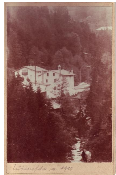
Pappfabrik von der Klamm aus gesehen, mit Anbau und Herrenhaus.
