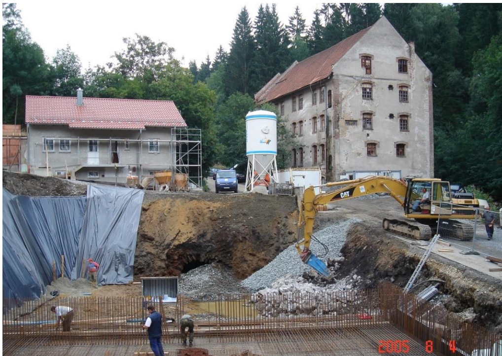
Wasserstollen zur ehemaligen Anwandtnersäge, sichtbar beim Umbau der Spiegelauer Kläranlage 2005
